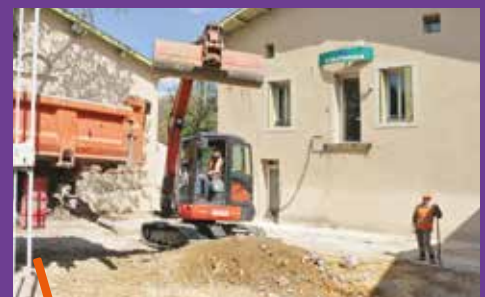
L'entrée et la façade de l'Écolothèque sont en cours de rénovation.
