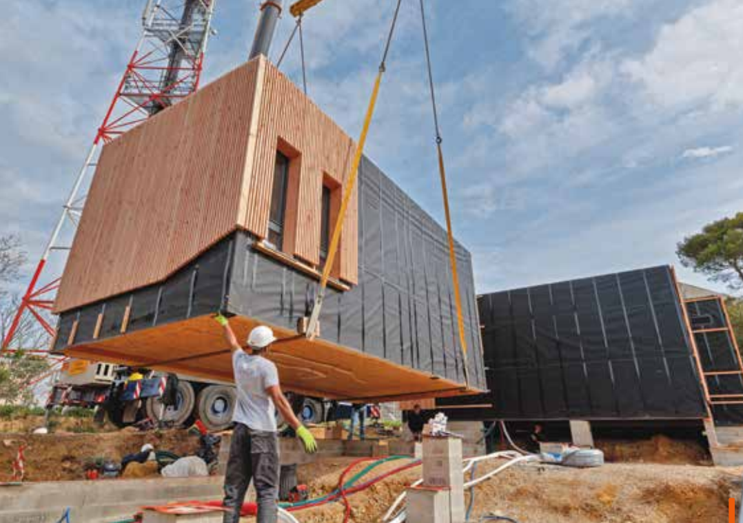
Le chantier d'éco-construction de la régie des eaux de Montpellier Méditerranée Métropole est en partie réalisé en modules bois préfabriqués en atelier et levés sur site.
